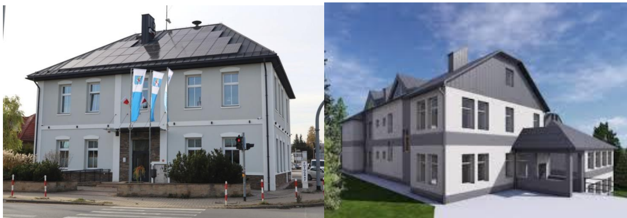
Budynek Urzędu Gminy oraz Szkoła Podstawowa w Januszowej po termomodernizacji
