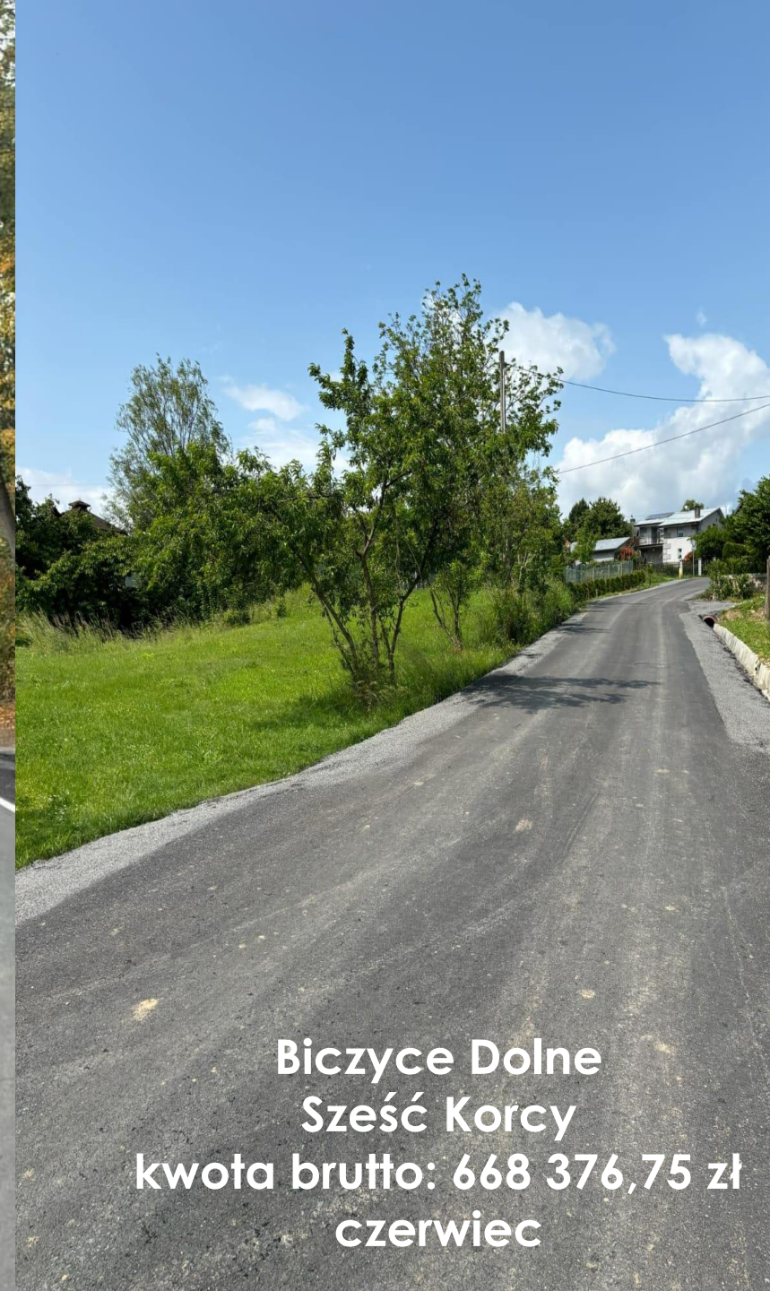
Wielopole Przebudowa ciągu drogowego w Wielopolu drogi gminnej do Wsi i ZHR kwota brutto: 1 356 670,01 zł październik
